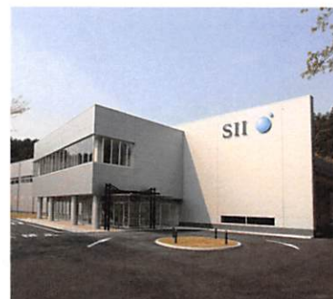
栃木本社ビル
