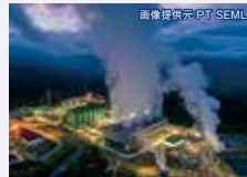
地熱発電設備
