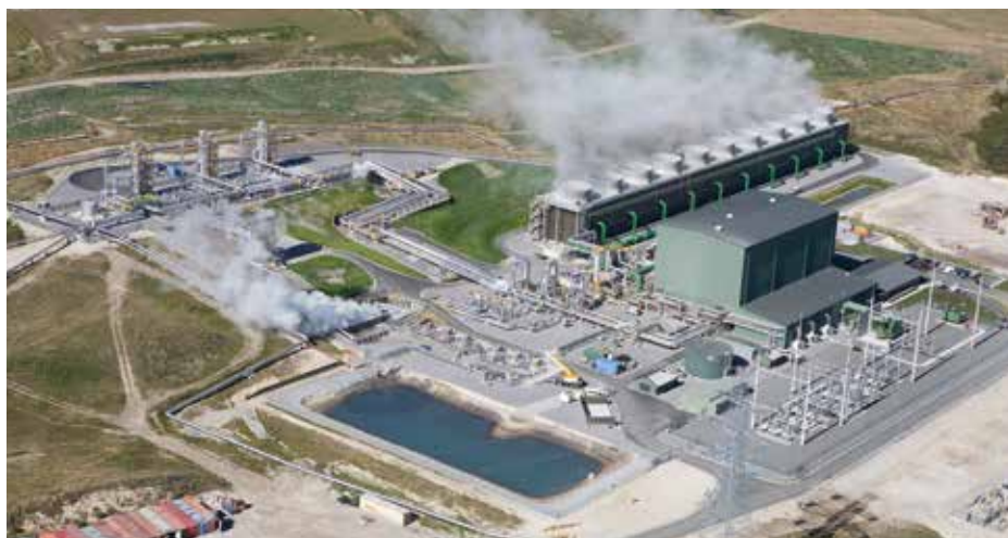
世界最大出力の地熱発電システム(ニュージーランド)
