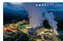
Muara Laboh Geothermal Power Plant (インドネシア)
