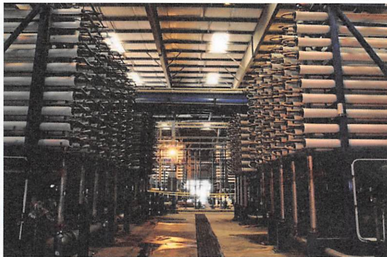
東レRO膜使用の海水淡水化プラント (トリニダード・トバゴ)
