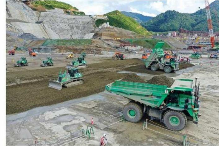
自動化施工システムA4CSEL®（自動運転中の建設機械群）
